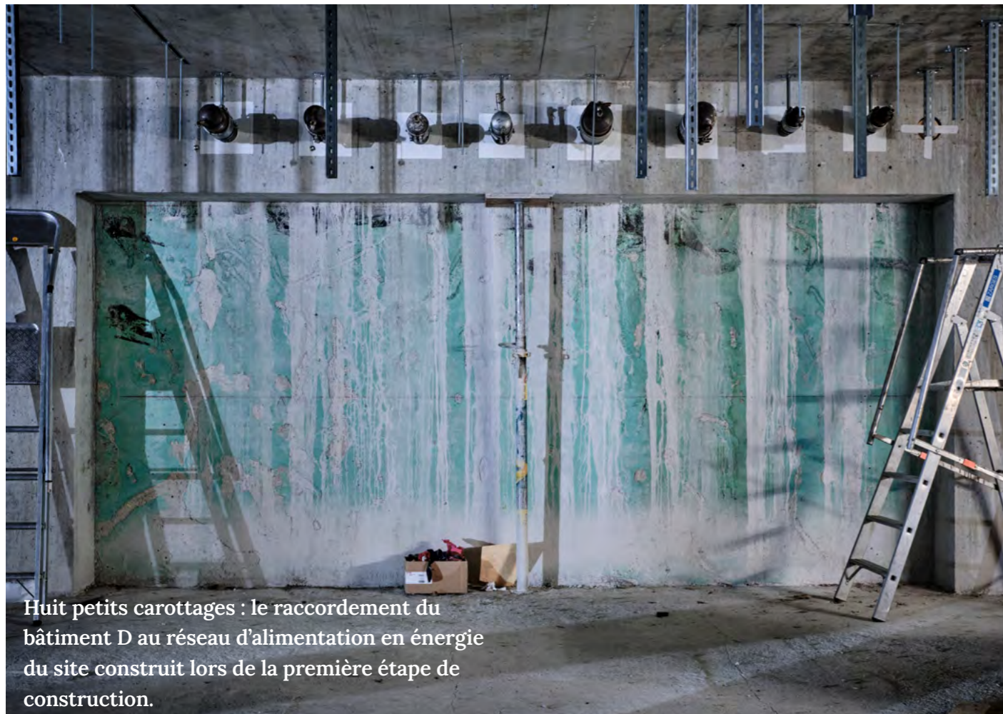
Détail des tuyaux de chauffage au 1 er sous-sol.
