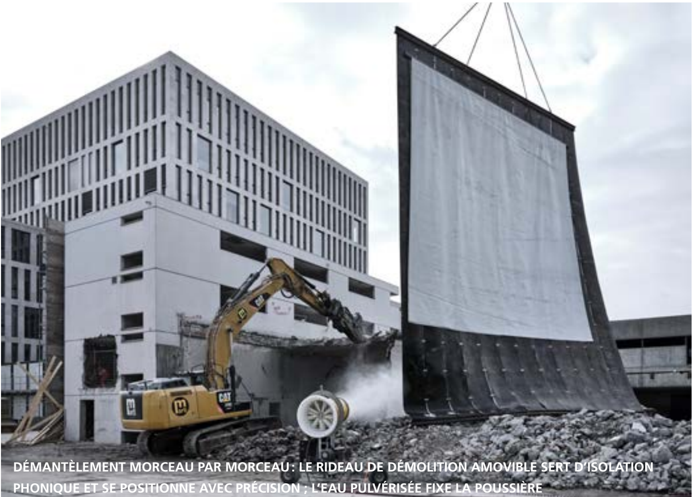
LA PALISSADE N'EST PAS ANCRÉE DANS LE SOL...
