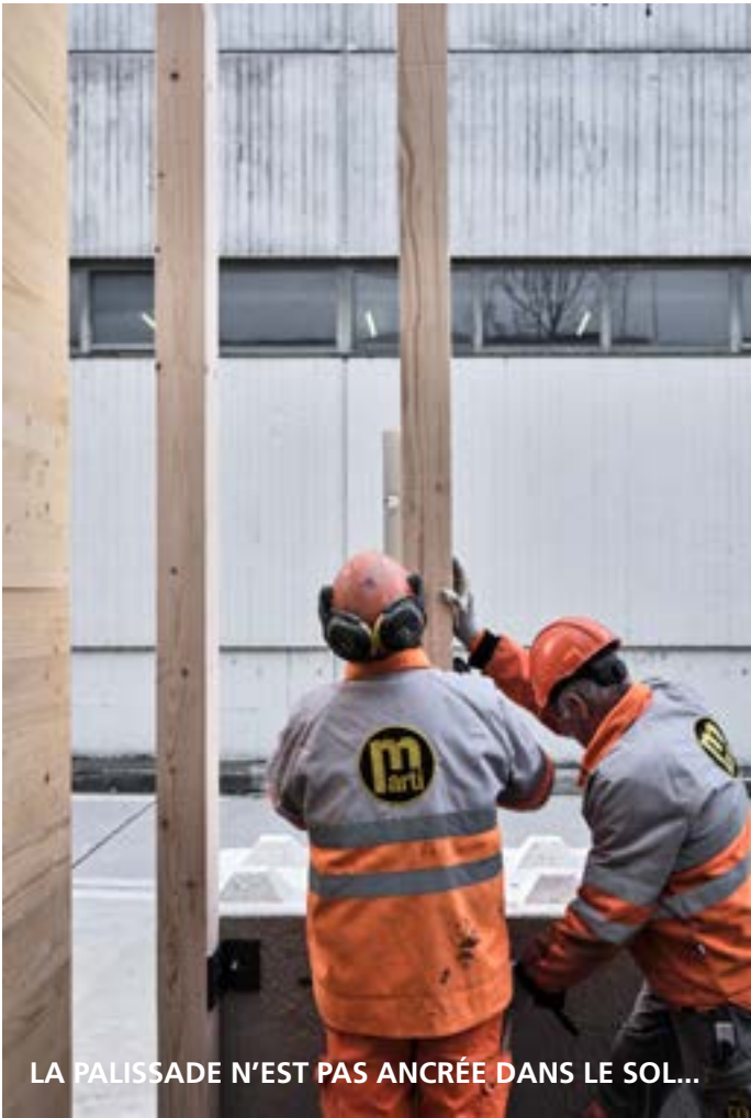
...ELLE EST STABILISÉE PAR DES POIDS EN BÉTON
