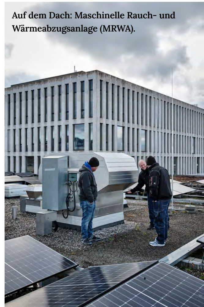
Gewaltiges Gebläse: Die Nachströmklappen für Frischluftzufuhr öffnen sich automatisch, wenn die MRWA ausgelöst wird.
