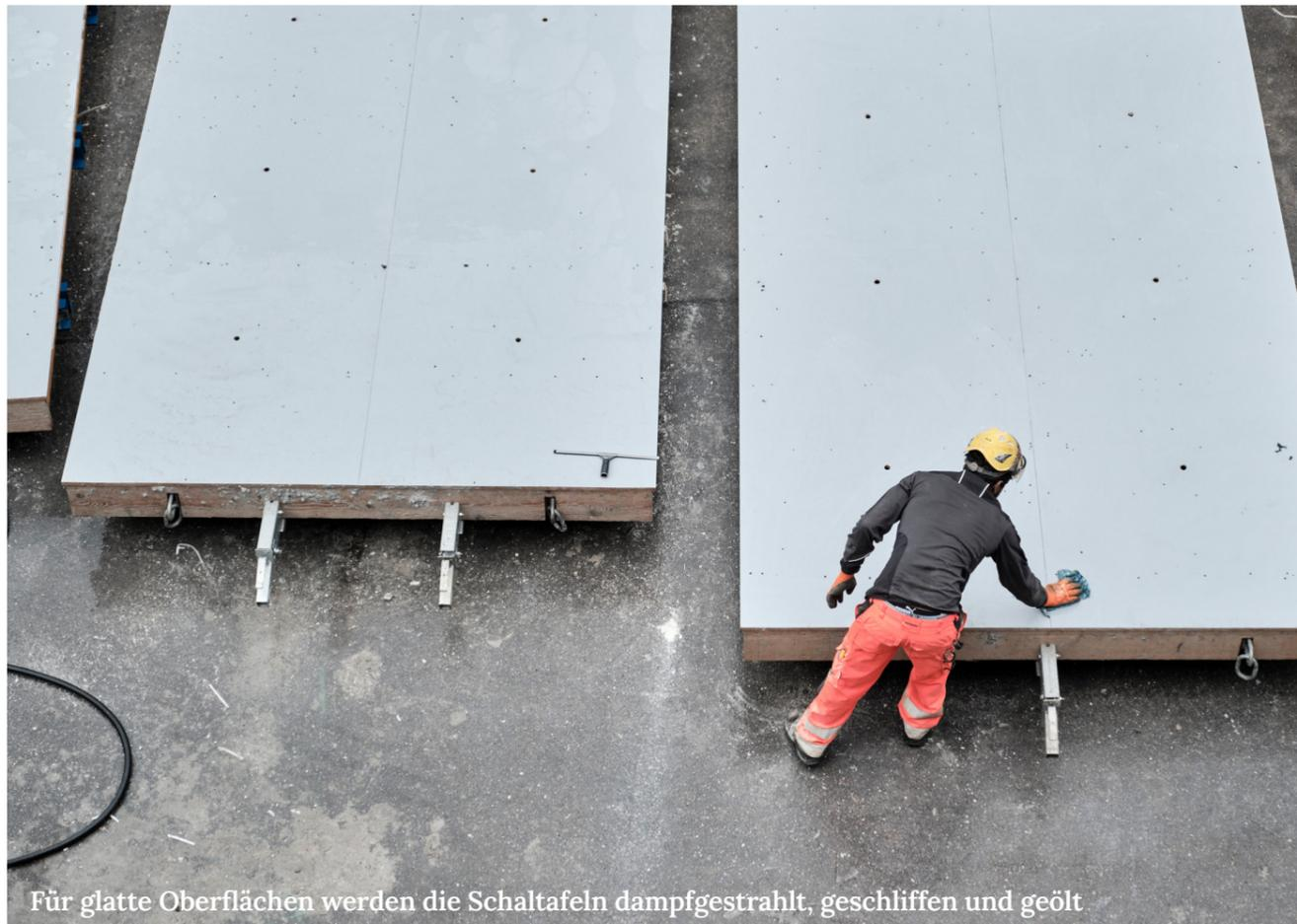
Für glatte Oberflächen werden die Schalttafeln dampfgestrahlt, geschliffen und geölt
